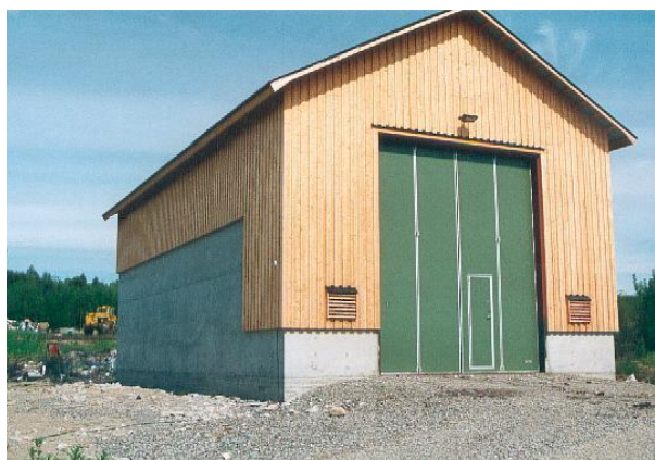
Bild 7: Mellanlagringshus för brännbara sopor.
