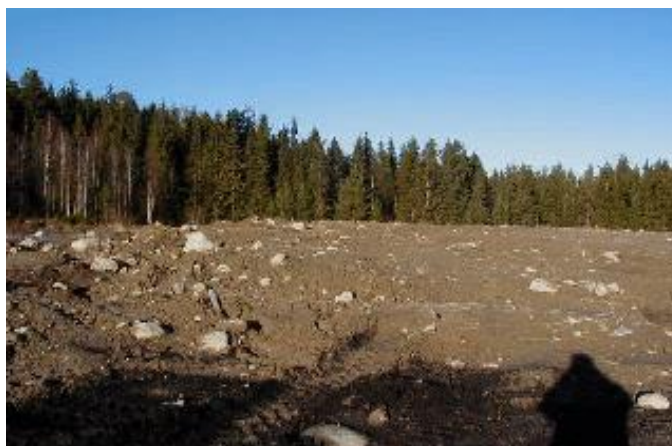
Bild 11: Schaktmassor till yttäckningen av soptippen i Kälarne 001027.
