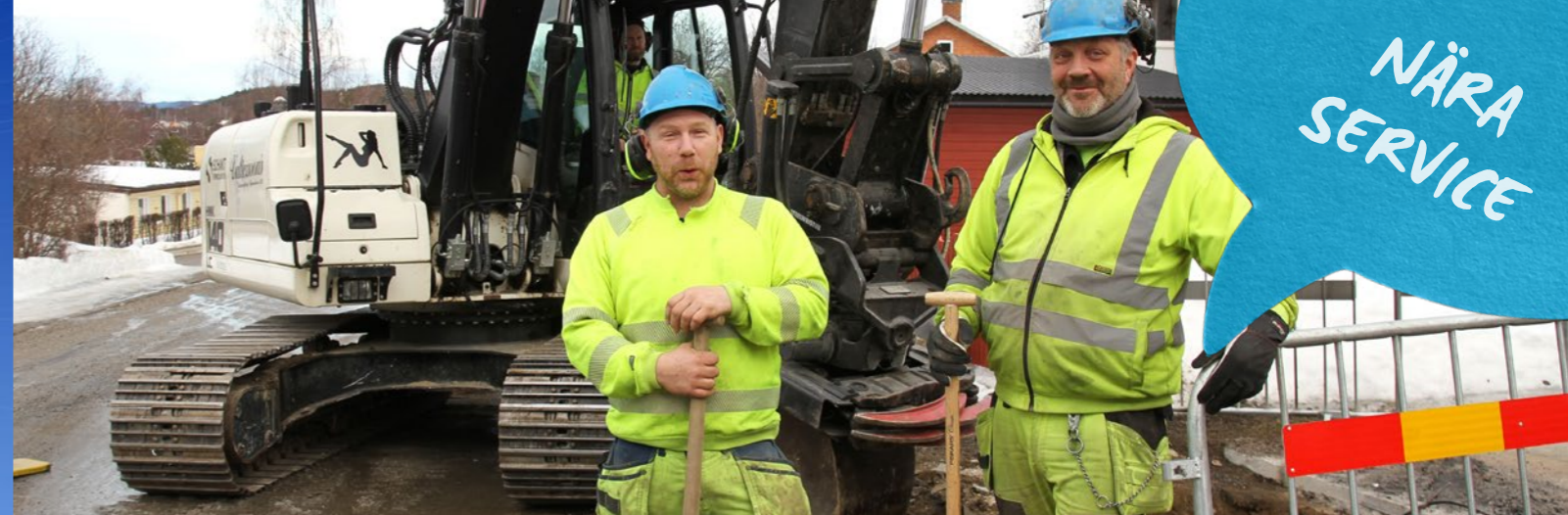
Bräcke kommuns driftstekniker David Malm och Mikael Östberg har tillsammans med grävmaskinist Jens Andersson under året bland annat jobbat med att renovera VA på Gränsgatan och Jämtlandsgatan i Bräcke.
